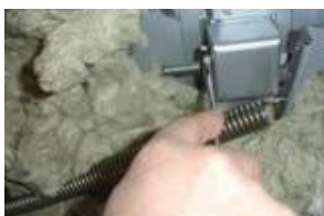
Fig. 2.5 Tighten door stop.
